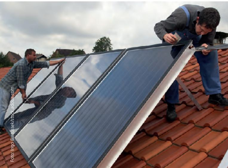
Eine Solarthermie-Anlage liefert Energie für die Warmwasserbereitung oder auch zur Unterstützung der Heizung. Möglich wird das mithilfe von flachen oder röhrenförmigen Sonnenkollektoren auf dem Dach, die schwarze Absorberflächen enthalten. Solarthermie-Anlagen sind nicht zu verwechseln mit Photovoltaik-Anlagen, die mit Solarzellen elektrischen Strom aus Sonnenlicht erzeugen.
